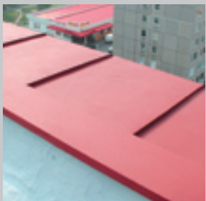
střeška s klempířskými prvky
