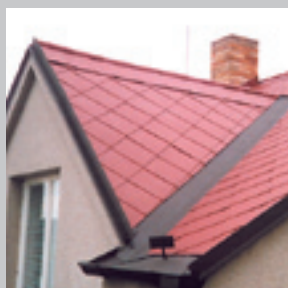
eternitová krytina po nátěru
